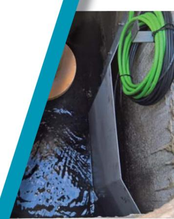
Befestigung der Ultraschallsensorik auf der Rückseite der Edelstahlwangen.
