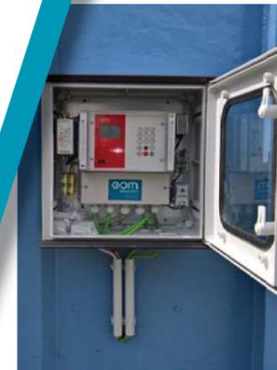
KATflow 150 Ultraschaldurchflussmesser mit zwei Messkanälen im Schaltschrank verbaut.
