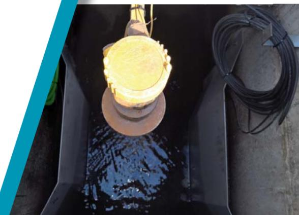
Verbaute Messwangen im Zulaufschacht der Kläranlage. Zur Niveaumessung kommen Radarsonden zum Einsatz.
